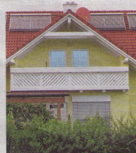
Der Kollektor auf einem Haus
